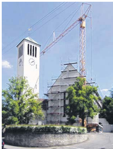
Dachrenovierung Andreaskirche, Foto: Günther Kempka
